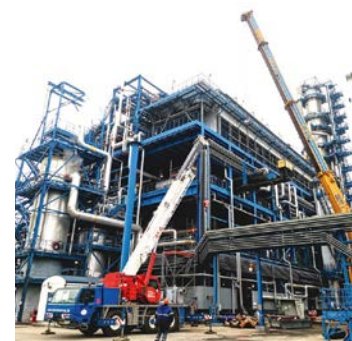
Выполнение работ по ремонту и замене технологического оборудования в период планового простоя Установки «АТ-9» (г. Омск)
