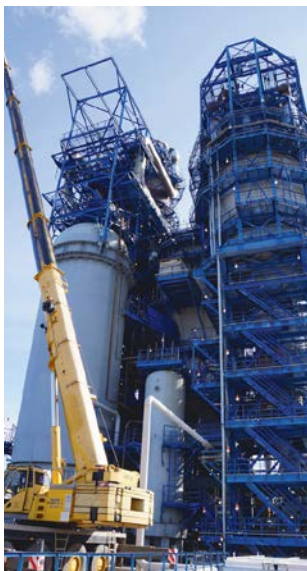
Выполнение работ по ремонту и замене технологического оборудования в период планового простоя Установки «КТ-1/1» (г. Омск)
