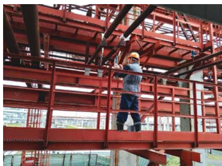
Генподрядные работы ОЗХ комплекса гидрокрекинга Теплоизоляционные материалы (г. Ачинск)
