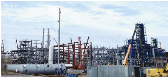
Строительство комплекса замедленного коксования (г. Орск)
