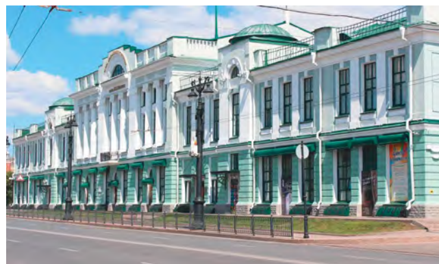
Работы по капитальному ремонту кровли БУКОО «Омский областной музей изобразительных искусств имени М. А. Врубеля» в рамках мероприятия «Проведение работ по сохранению объекта культурного наследия народов Российской Федерации регионального значения «Городской торговый корпус»
