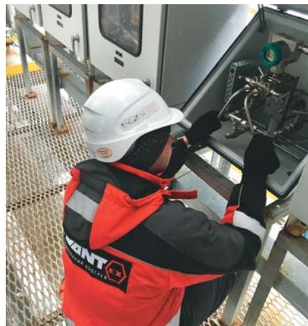
При выполнении предпроектного обследования подбираются оборудование и материалы системы электрообогрева, необходимые именно для данного объекта. При необходимости предусматривается система управления и предиктивной диагностики для своевременного принятия решений и предупреждения аварийных ремонтов системы электрообогрева.
